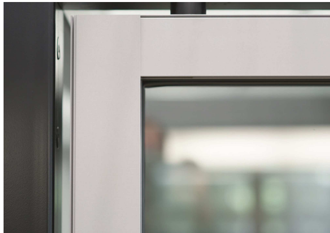
Dettaglio giunzione telaio-anta
